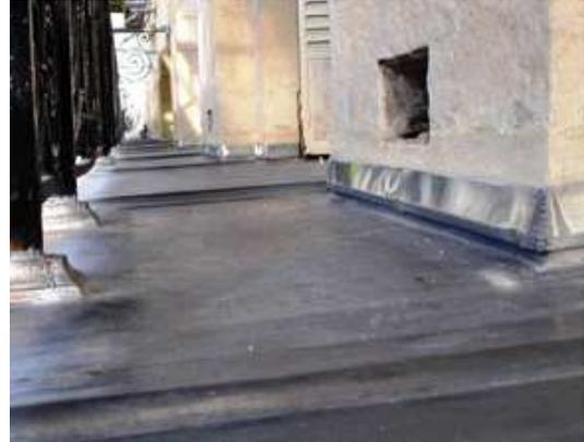
Figure 27 : Protection en plomb d'un balcon.
