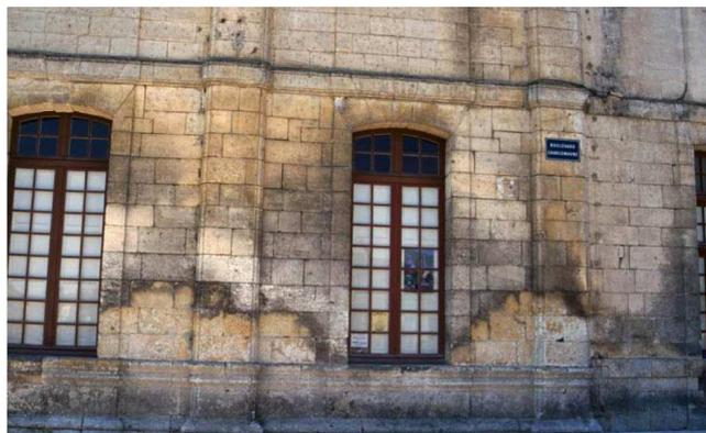
Figure 28 : Exemple de remontées capillaires
