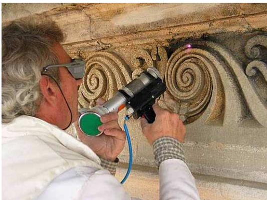
Figure 48 : Utilisation d'un laser à rayon ponctuel
