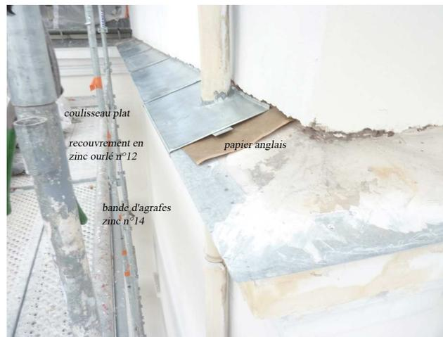
Figure 25 : Protection d'une saillie par bandes de zinc
