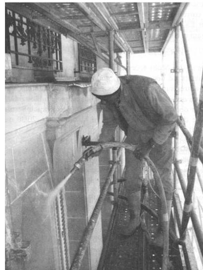
Figure 46 : Mise en œuvre de l'hydrogommage
