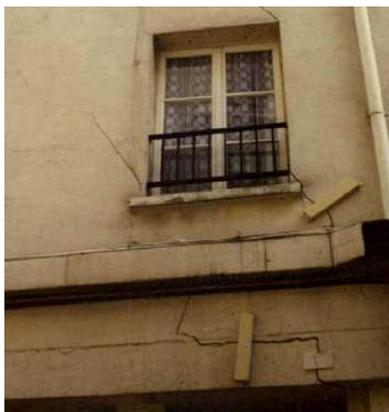
Figure 71 : Exemples de patins de plâtre chevauchant des fissures
