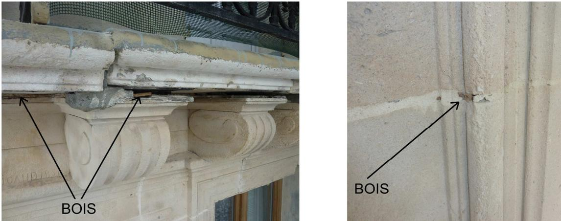
Figure 41 : Exemples de résidus en bois insérés dans la maçonnerie
