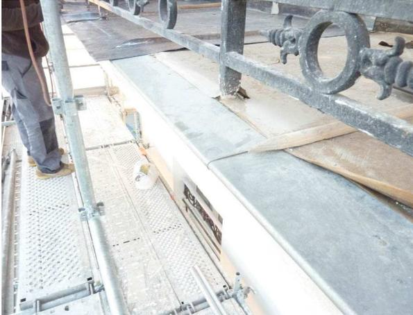
Figure 26 : Pose de bandes de plomb sur un balcon
